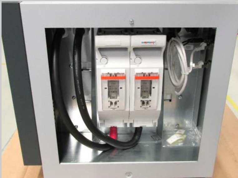
Obrázek 4-7: akumulátorový systém, boční pohled na otevřenou skříň
