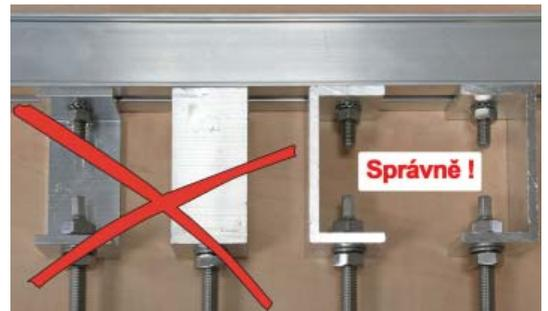
Obr. 7: Základní přehled kotvicích prvků
